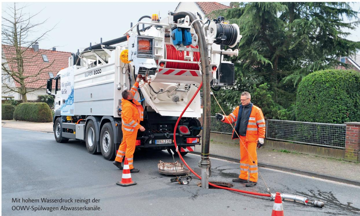
Mit hohem Wasserdruck reinigt der OOWV-Spülwagen Abwasserkanäle.
