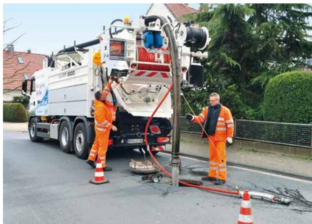
*Kraftprotz: Mit hohem Wasserdruck reinigt der OÖWV-Spülwagen Abwasserkanäle.*
