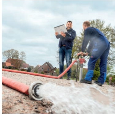
Die neue Betriebsstelle in Schortens: Modern und kundennah
