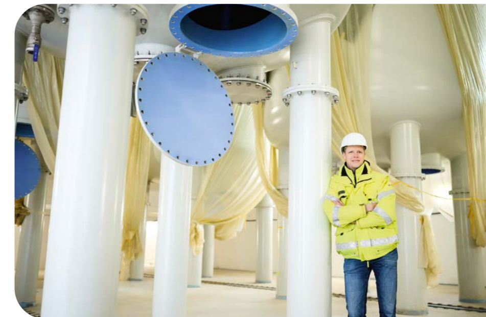
Nach der Fertigstellung werden die Kessel mit Filterkies befüllt
