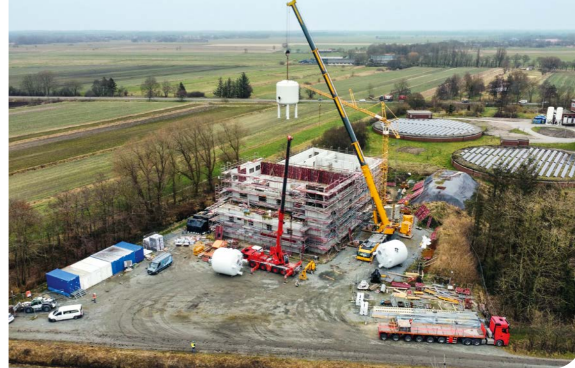
Die Filterkessel schweben im Februar 2023 in den offenen Rohbau
