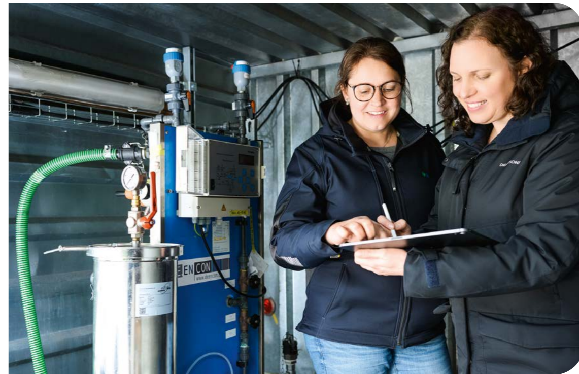
Die Versuchsanlage auf der Kläranlage Brake zeigt, dass eine Aufbereitung machbar ist
