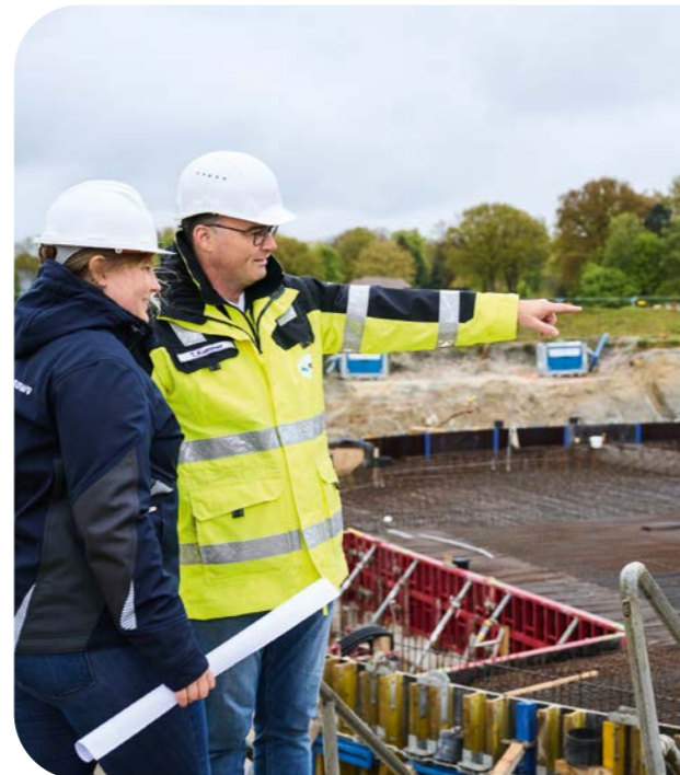
Gemeinsam arbeiten die OOWV-Fachabteilungen an einer Verbesserung der Drucksituation im Süden
